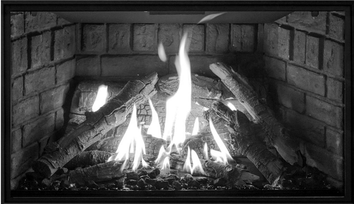
**Figure 51. installation correcte et apparence de la flamme**
