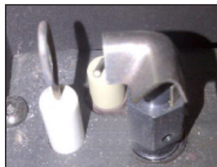
Figure 23: position correcte de la veilleuse
