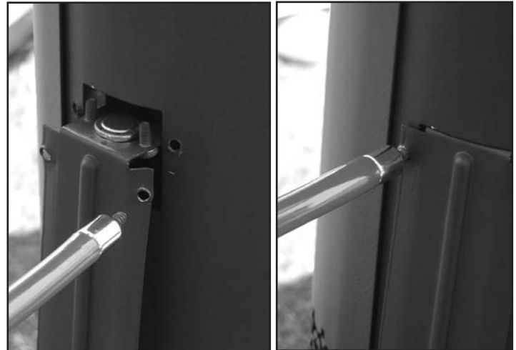
Figure 40: installation de l'interrupteur de
