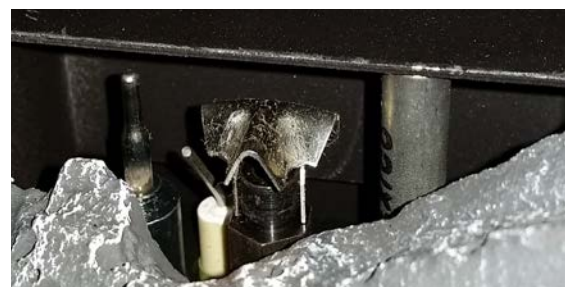
Figure 21: L'assemblage de la veilleuse à côté du brûleur.
