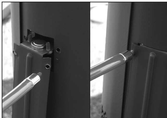
Figure 44: Installation du commutateur de déversement.
