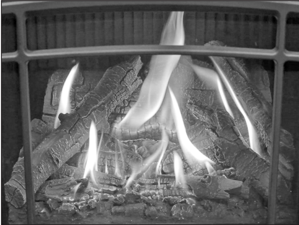
Figure 53. Brûlure et flamme appropriées
