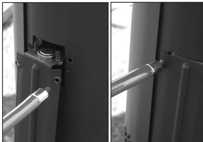
Figure 47: installation de l'interrupteur de déversement
