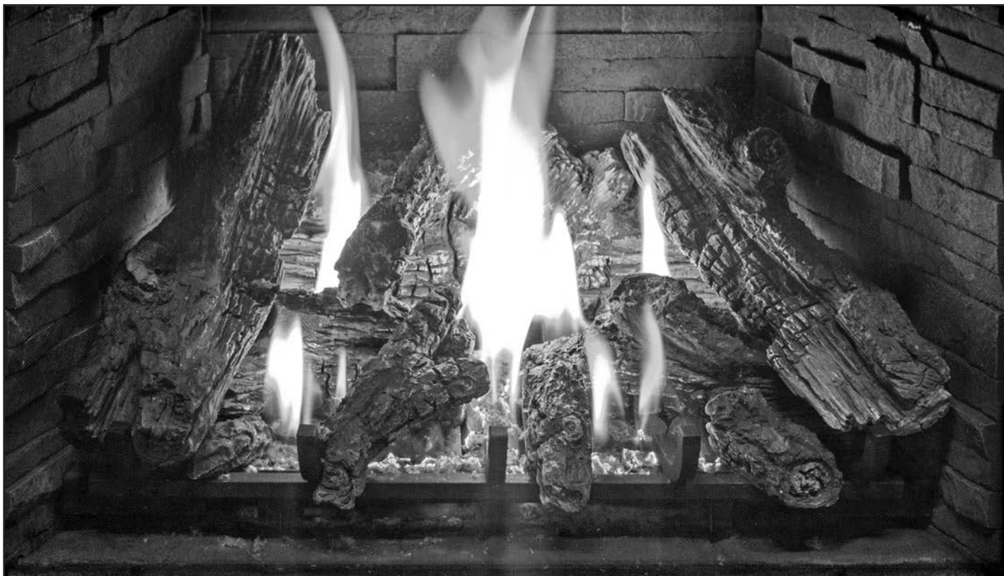
Figure 62: installation correcte et apparence de flamme
