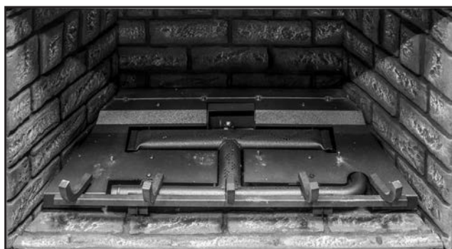
Figure 35: la boîte à feu avec jeu de bûches et supports retirés
