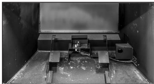
Figure 40: La doublure arrière peut maintenant être enlevée. Utilisez un aspirateur pour nettoyer la boîte à feu nue si nécessaire.
