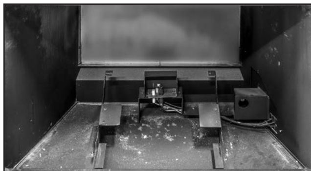
Figure 52: La doublure arrière peut maintenant être enlevée. Utilisez un aspirateur pour nettoyer la boîte à feu nue si nécessaire.
