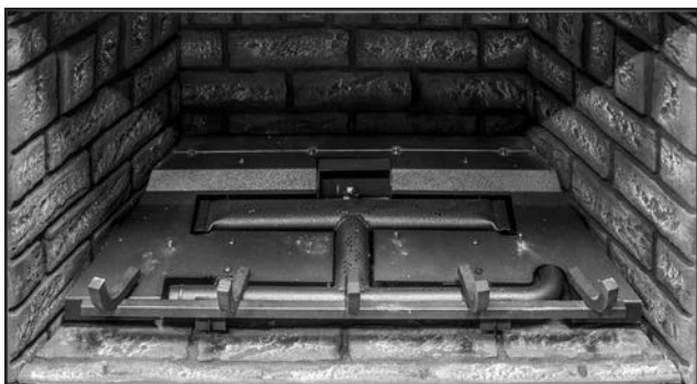
Figure 47: la boîte à feu avec jeu de bûches et supports retirés
