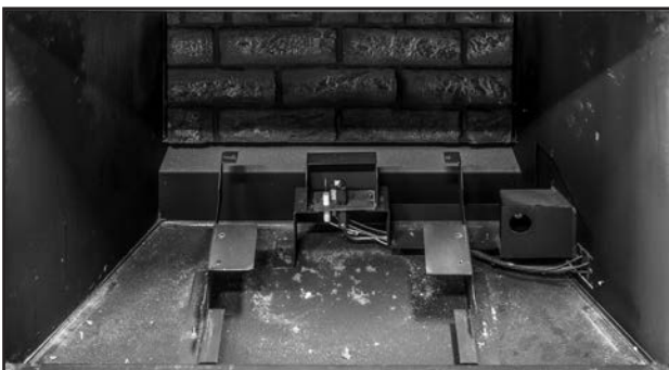
Figure 42: Soulevez le brûleur des supports et retirez-le de la boîte d'entrée. Dévissez les supports de panneau (T20) de chaque côté du déflecteur pour enlever les doublures latérales gauche et droite.
