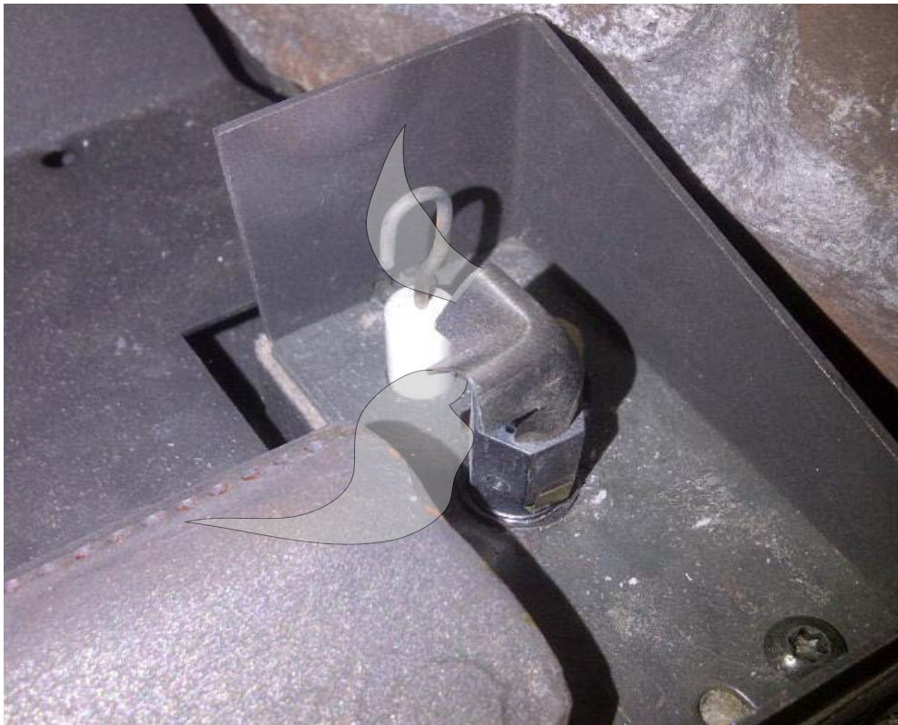
Figure 23. Corriger Brûleur et veilleuse Bouclier Placement (Q1I Montré mais semblable à Q2I)
