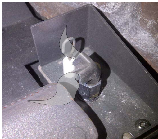
Figure 22: Orientation correcte du pilote et de la protection du pilote
