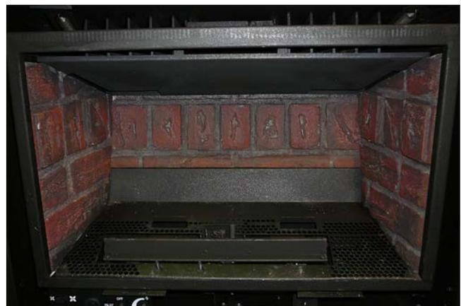
Figure 58: Panneau de Brique en place
