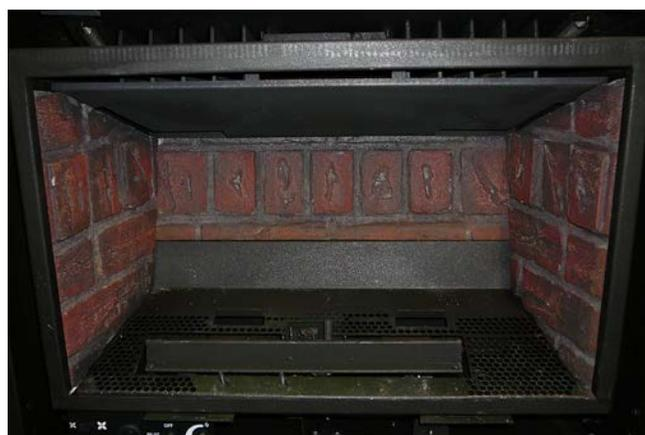
Figure 66: Panneau de Brique en place
