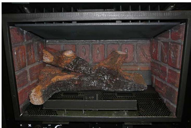
Figure 69. Deuxième étage d'installation des rondins.
