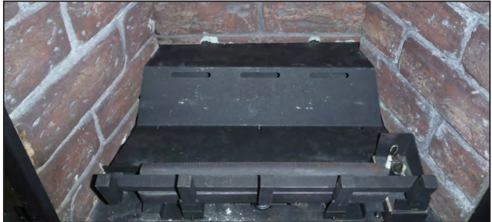
Figure 35. Foyer vide avec grille et localisation broches.
