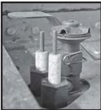
Figure 73: Ensemble de veilleuse du Trenton
