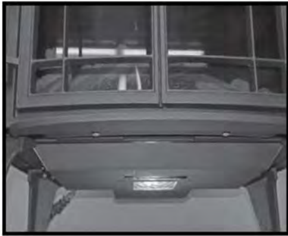
Figure 60: Panneau du support à lentille
