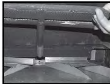
Figure 70: Brûleur retiré de son orifice
