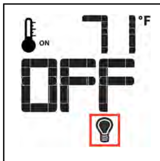
Fig. 17: Éclairage éteint sous le poêle
