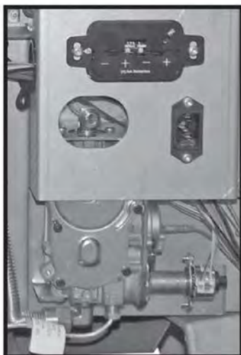
Figure 74: Emplacement de la valve de contrôle de gaz
