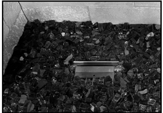
Figure 11.5 Gabarit de mise en place du support retiré
