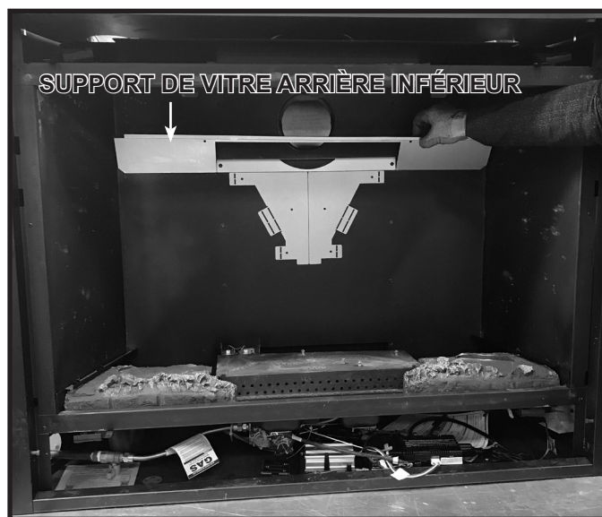
Figure 11.8 Retrait du support de vitre arrière inférieur
