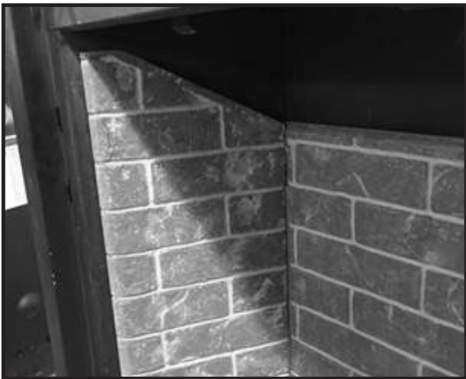
Figure 11.3 Installation du panneau réfractaire gauche
