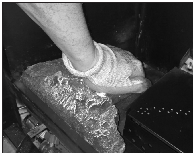
Figure 11.1 Appuyez sur le côté gauche de l'âtre pour le fixer solidement
