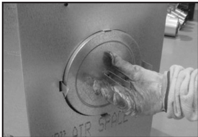
Figure 6.10 (foyer générique illustré) Repliez vers l'extérieur les parties centrales de la bande de retenue et utilisez-les pour enlever le couvercle du conduit.
