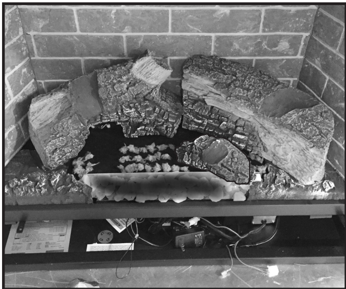
Figure 6. Bûche du brûleur installée
