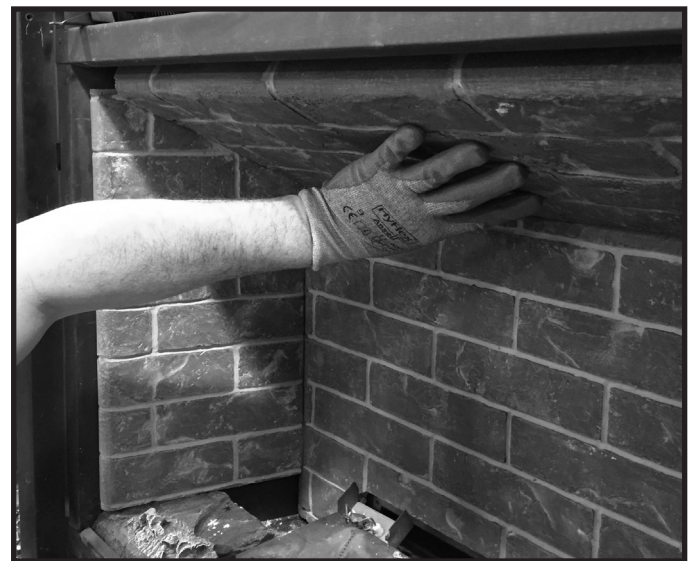
Figure 11.5 Installation du panneau réfractaire droit
