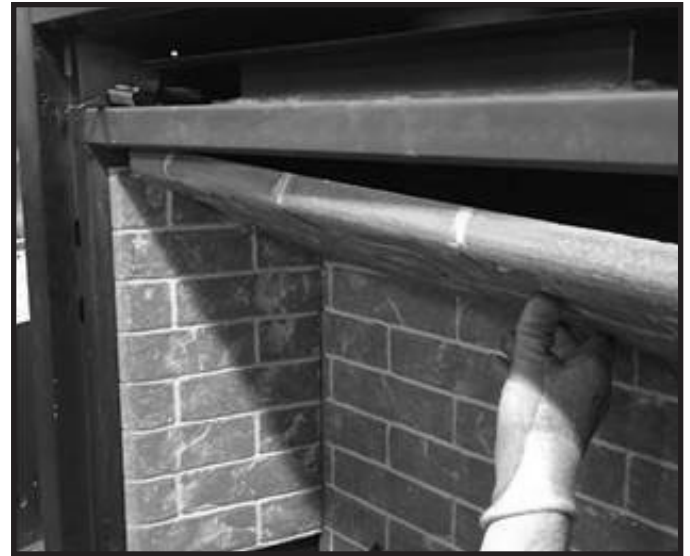
Figure 11.4 Installation du panneau réfractaire supérieur
