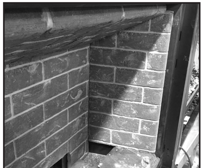
Figure 11.6 Panneau du réfractaire droit installé
