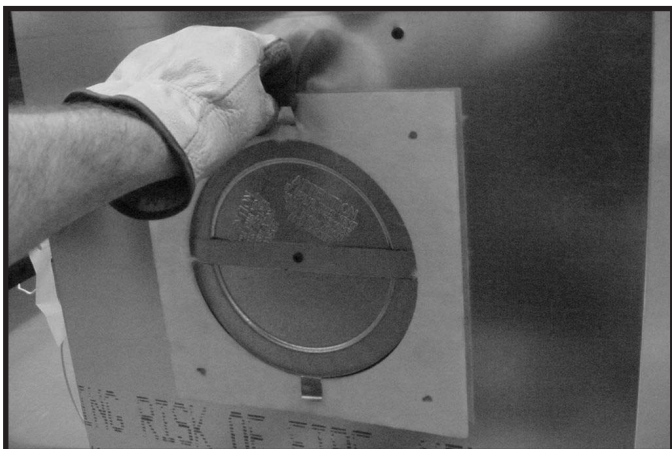
Figure 6.8 (foyer générique illustré) Pliez les languettes vers le centre du branchement au feu (90°) puis enlevez le joint d'isolant.
