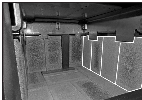
Figure 33: Briques posées sur le mur droit.
