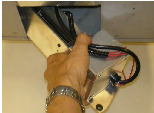
Glissez le ventilateur Z46FK dans l'ouverture.
