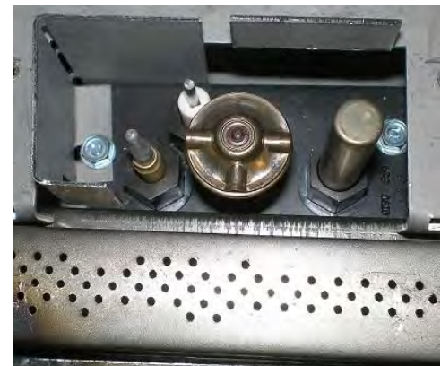
La veilleuse doit maintenir ce rapport avec le brûleur
